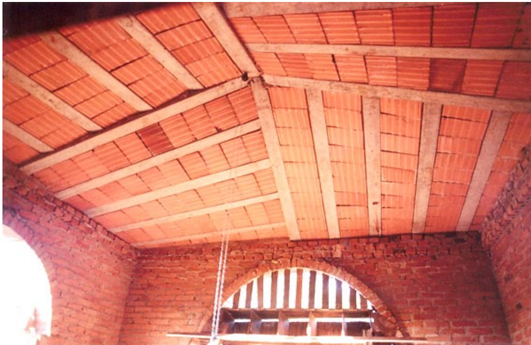
Laje com vigotas recíprocas em galinheiro Botucatu
