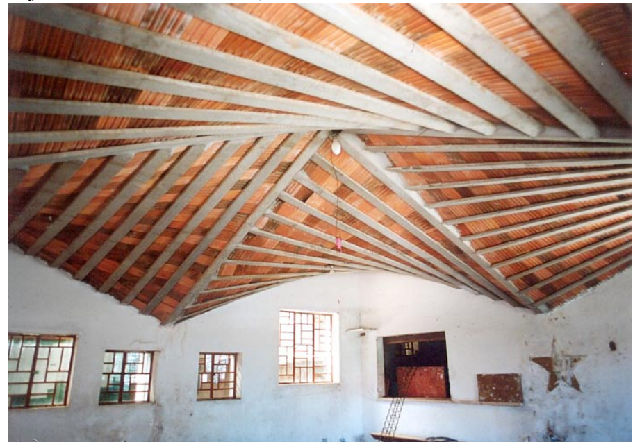
Laje no Centro Comunitário, mutirão Vista Linda
