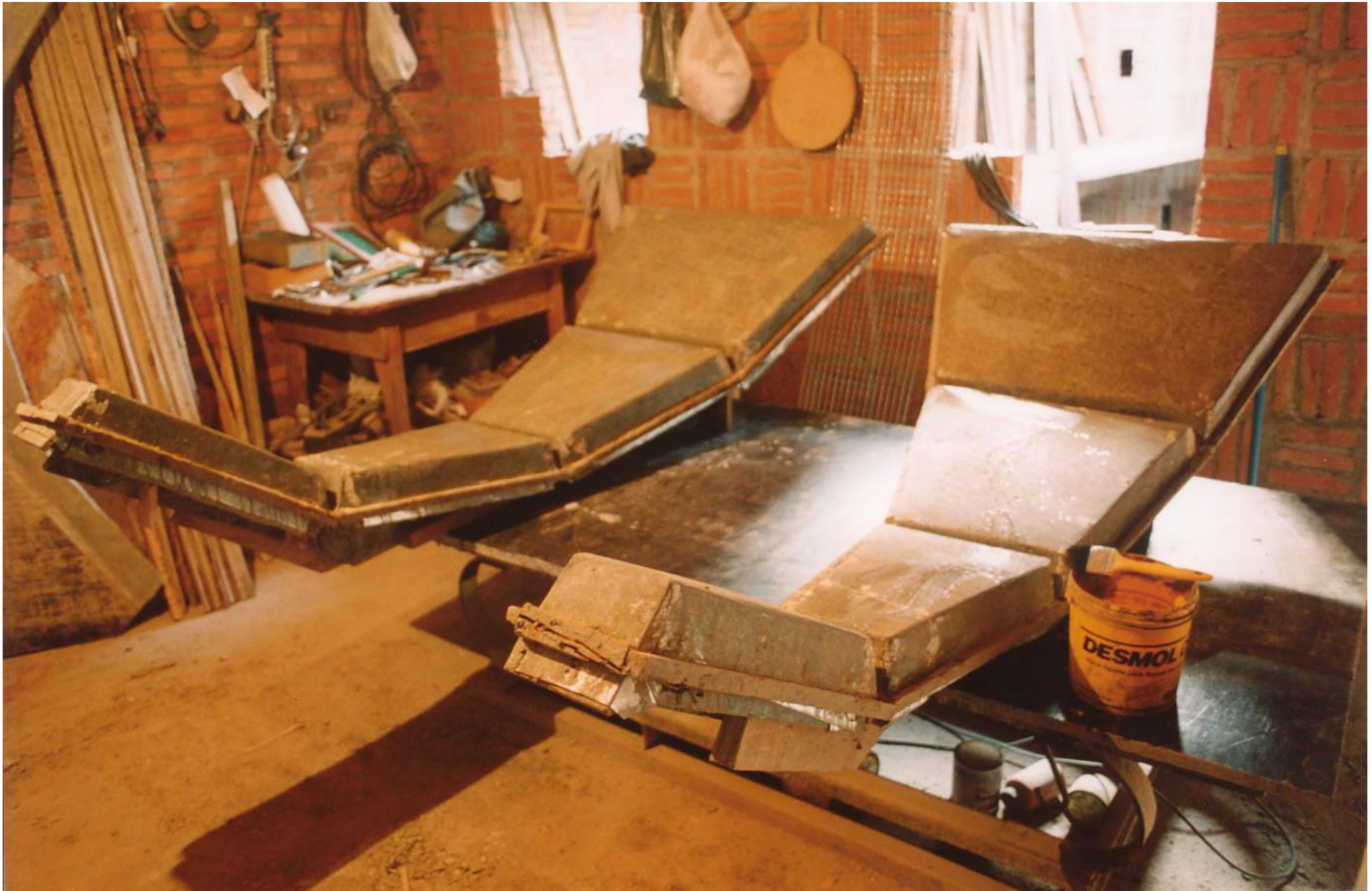
As formas foram feitas em madeira revestidas com chapa galvanizada
